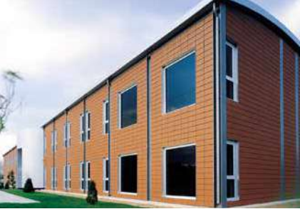
Trakya Döküm Sosyal Tesis Binası Kırklareli
